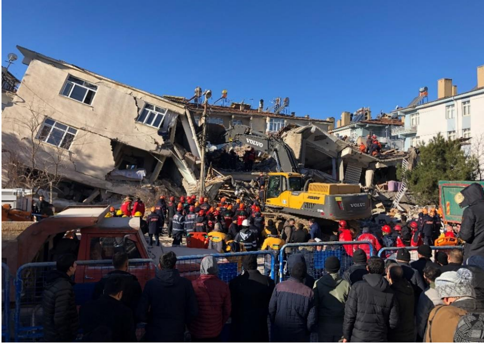
Foto 1. 24 Ocak 2020 Sivrice-Elazığ depreminde yıkılan Dilek Apartmanı.
